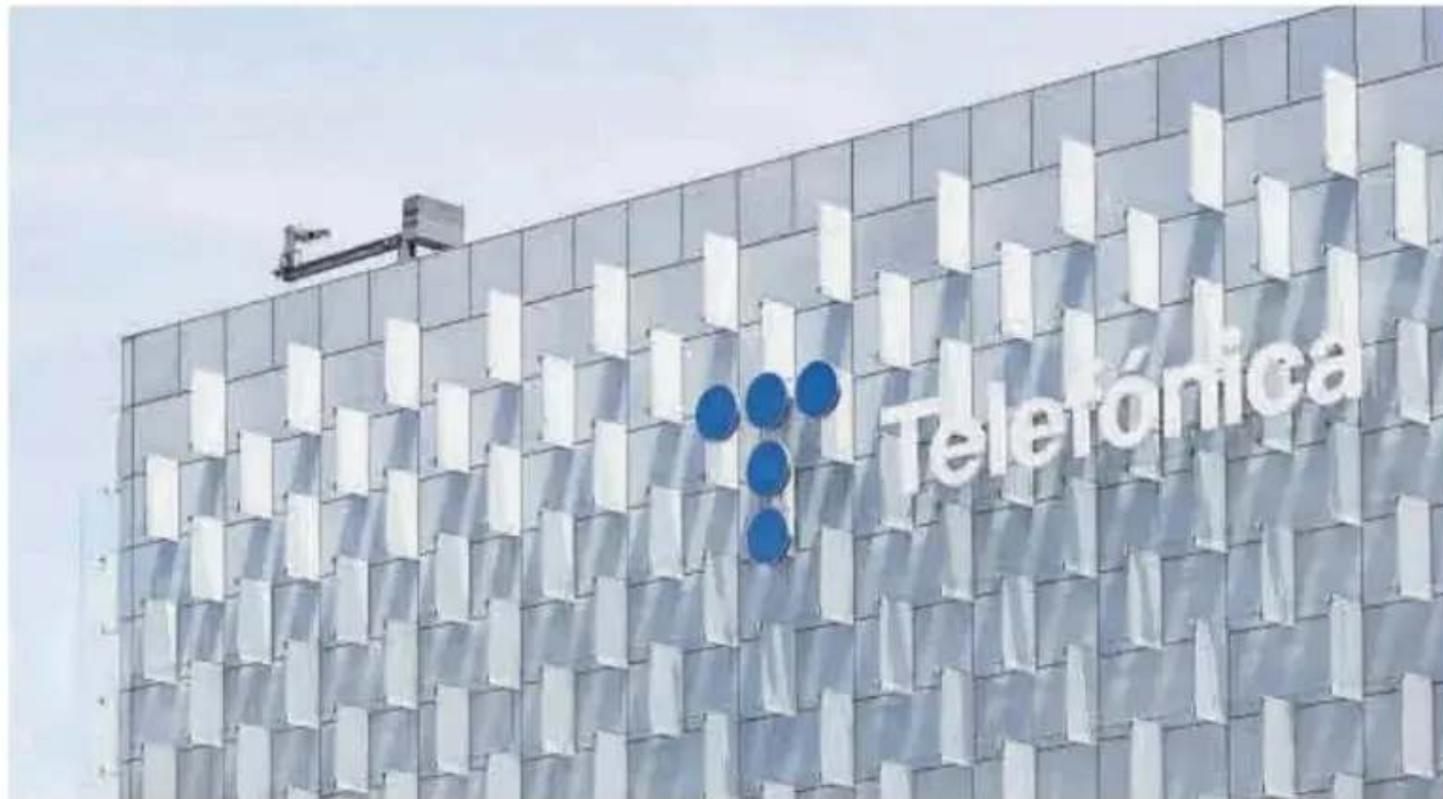
Fachada del edificio de Distrito Telefónica.
