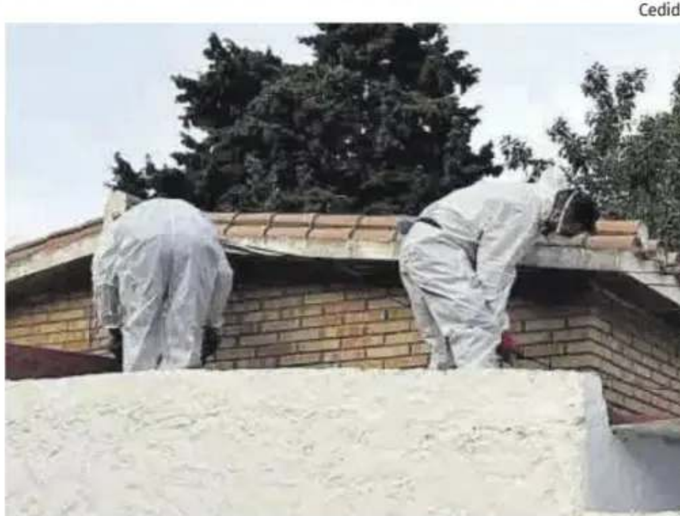
Operarios retiran amianto de una cubierta.
